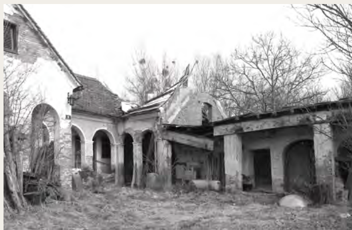
Das Hutter-Haus, kurz vor dem Abriss
