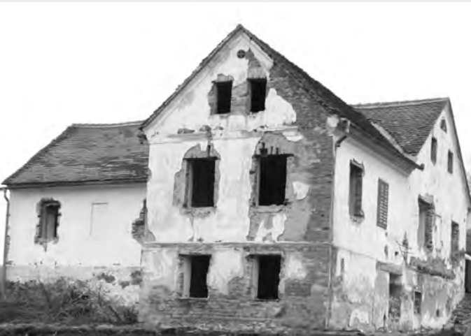
Das "Lederzieger-Haus" beim Abbruch.
