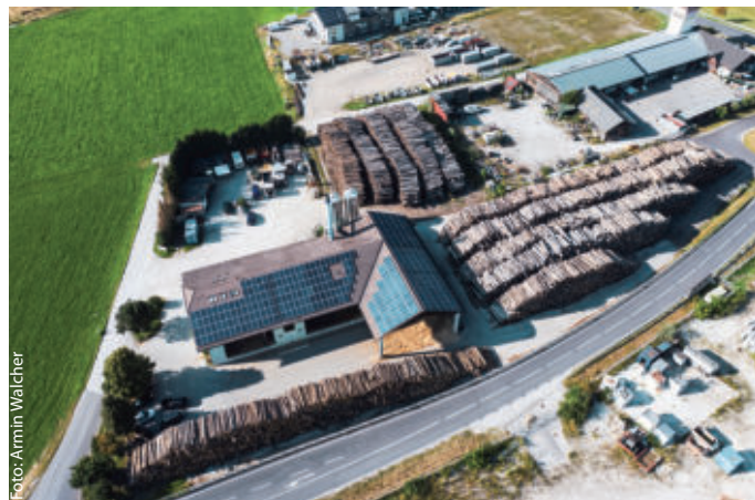
Mehr als 90% des Wärmebedarfs von Irdning und Raumberg werden aktuell von der Bioenergie Irdning gedeckt
