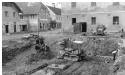
Baugrube beim „Gasthof zur Post“ in Stainach, 1960
