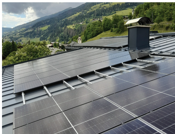
Installation PV-Anlage auf dem Gemeindehaus
