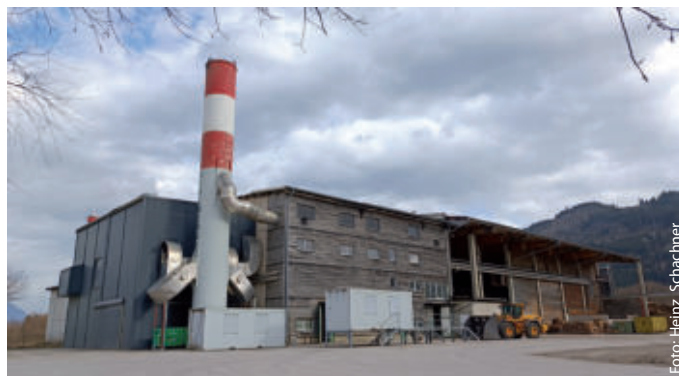
Biomasse-Heizwerk der Landgenossenschaft Ennstal
