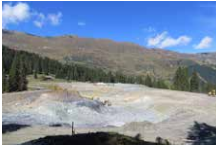
Speicherteich Hög Gesamtansicht. ¼ des Aus-hubs ist noch zu erledigen.
