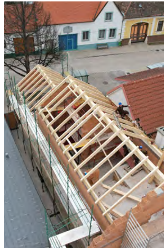
Der Dachstuhl mitten in seiner Errichtung
