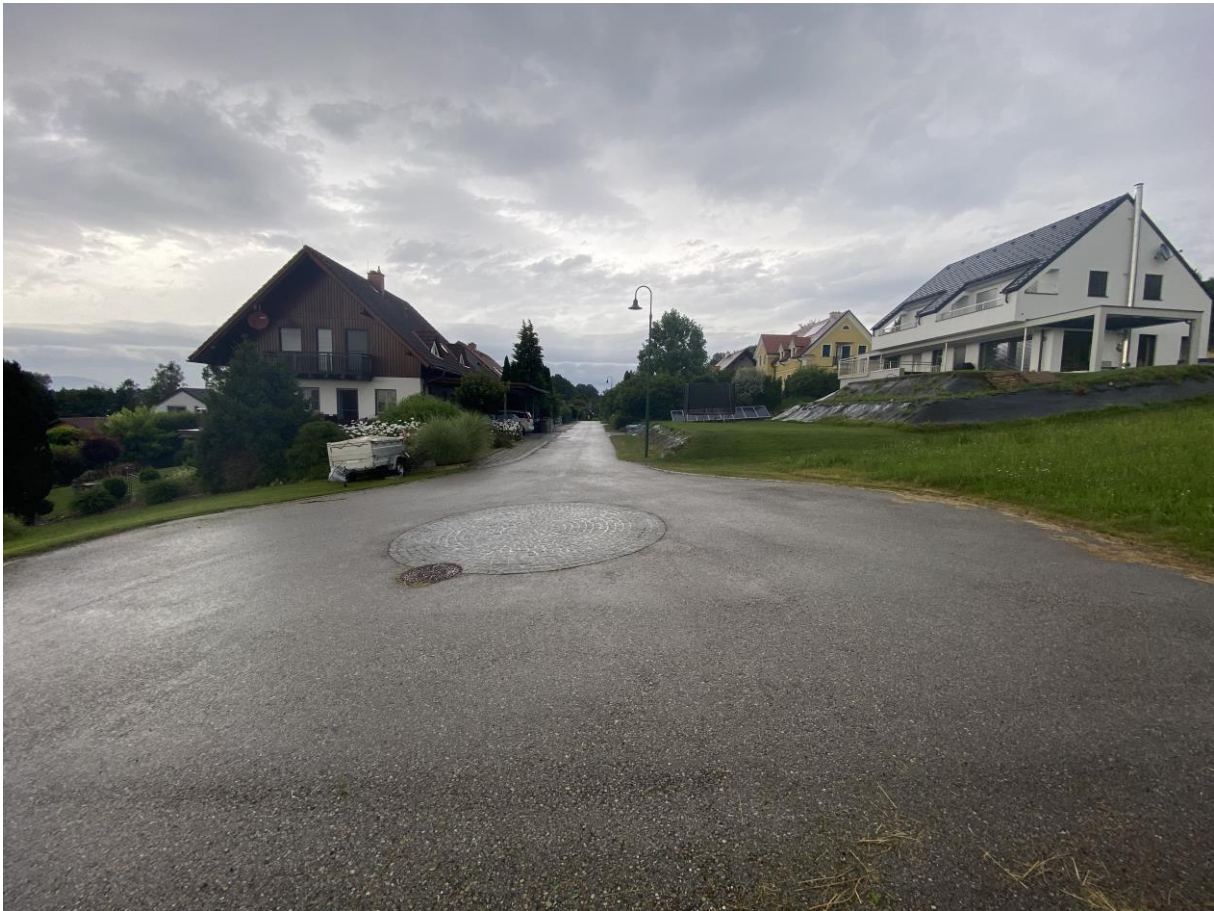
Abb. 6: Blick auf die Zufahrt Richtung Norden
