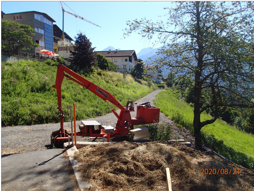
Foto 7: Blick Richtung Südost auf E07. Nordwestlich grenzt ein landwirtschaftliches Gebäude an.
