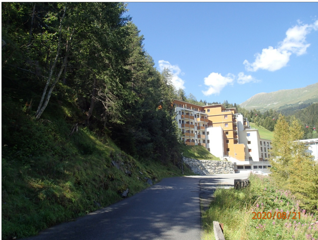
Foto 1: Blick Richtung Südwesten. Der bauliche Entwicklungsbereich E06 schließt an das bestehende Personalwohnhaus der Komperdell-Seilbahnen an.
