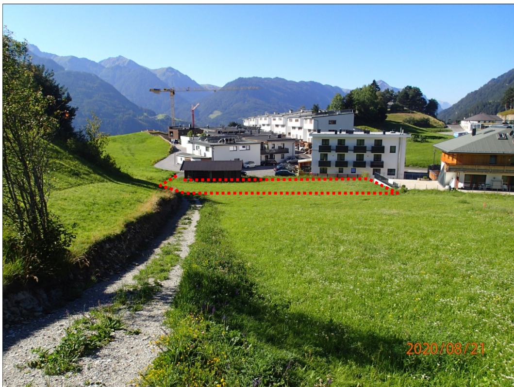
Foto 14: Blick Richtung Süden auf den baulichen Entwicklungsbereich E10 im Ortsteil Lourdes.
