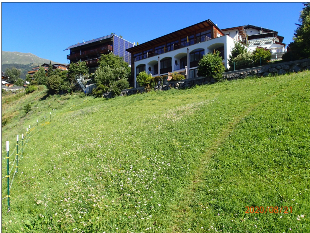
Foto 9: Nördlich grenzen Wohngebäude und Gebäude mit Ferienwohnungen an.
