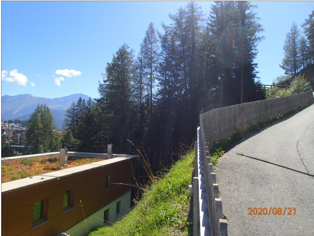
Foto 3: Blick Richtung Südosten von der bergseitig verlaufenden Straße auf das bestehende Personalwohnhaus und die bauliche Entwicklungsfläche E06.
