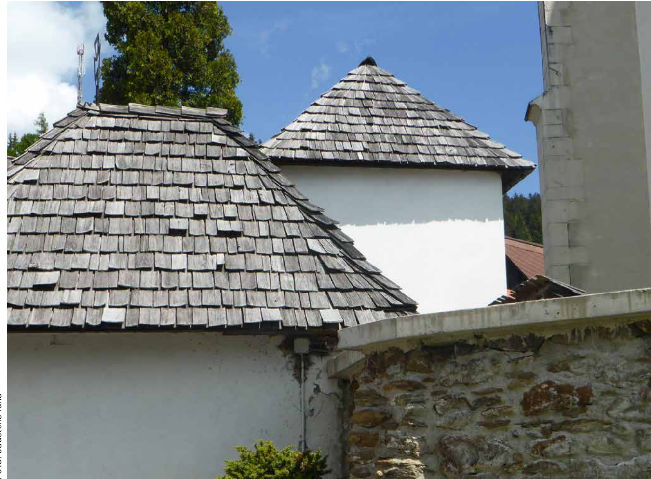
Foto: baustelle land
