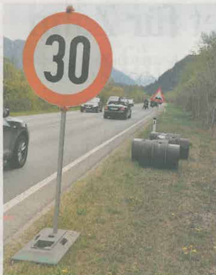
Die Asphaltdecke auf der Fernpassstraße bei Musau wurde bereits abgefräst. Über die Feiertage konnte der Verkehr ungehindert rollen. Foto: Mittermayr
