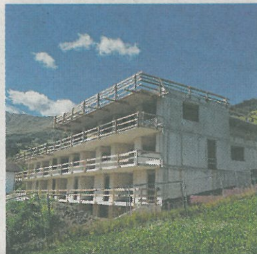
Im Oberdorfweg entstehen für ca. 2,7 Mio. Euro 17 neue Wohneinheiten.
