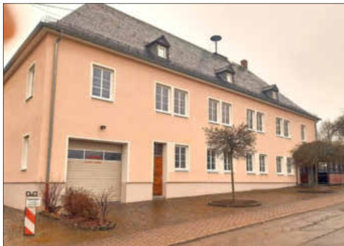
Die Dorf-Büros sind im EG untergebracht, ebenso Küche und Konferenzraum. Bild: Dorfgemeinschaftshaus Horbruch
