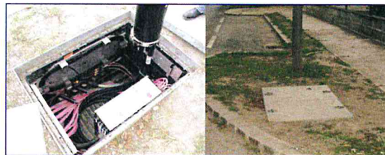
Faserverteiler - unterirdisch
